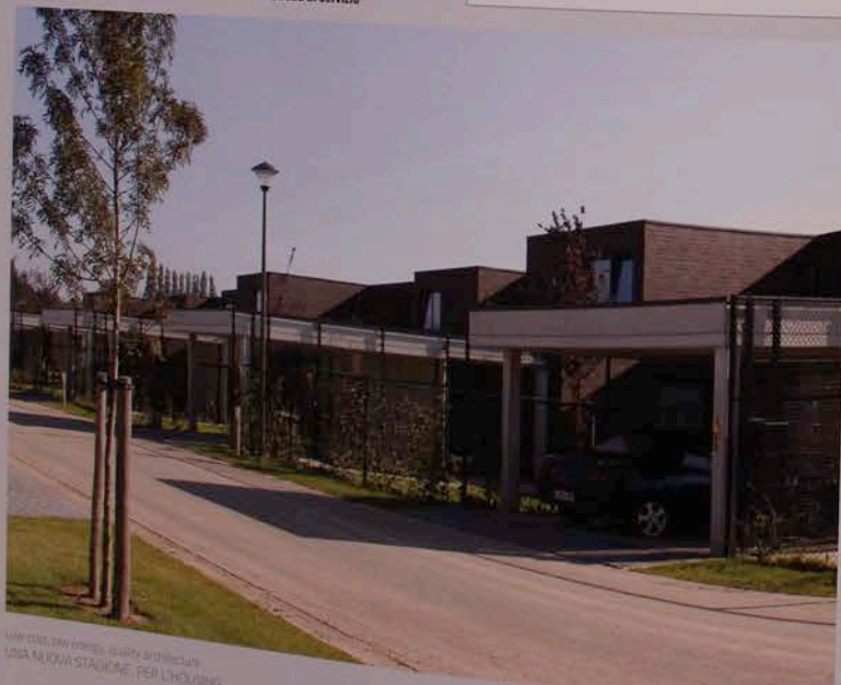
↓ De Mot", in evidenza i box auto che si affacciano sulle strade di servizio
